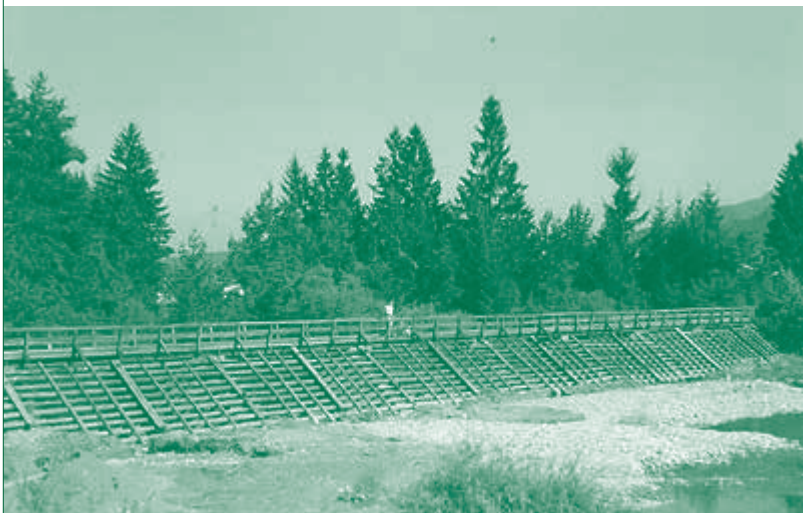
Die Rechenanlage beim Muntlinger Steg war ursprünglich 80 Meter lang. Schwere Sockel waren notwendig, um dem gewaltigen Druck von bis zu 3.200 Raummetern Holz standzuhalten.
