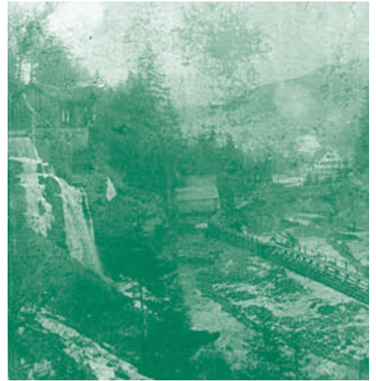
Eine der ältesten Fotografien der Triftanlage zeigt die Funktion der „Böcke“, welche das Bachbett querten, um das angeschwemmte Holz in den Triftkanal zu leiten.
