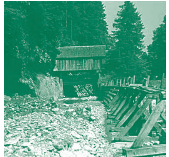
Das „Eichenhaus“ mit seinen mächtigen Balken diente zur Regulierung des Zuflusses zum Triftkanal.
