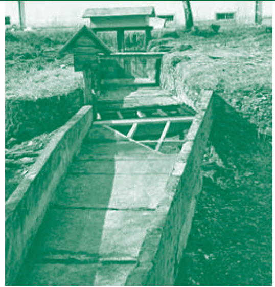
Entlang des Flözkanals befinden sich zwei „Sandläden“, mit deren Hilfe Sand und Kies in die seitlichen Sammelbecken geschwemmt werden konnte.
