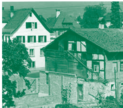
Blick auf die Rückseite des „Gauhauses“ und des in Bau befindlichen Büros der Generali-Versicherung. Auf der anderen Straßenseite links ist das ehemalige Gasthaus zum Schiff zu sehen.
