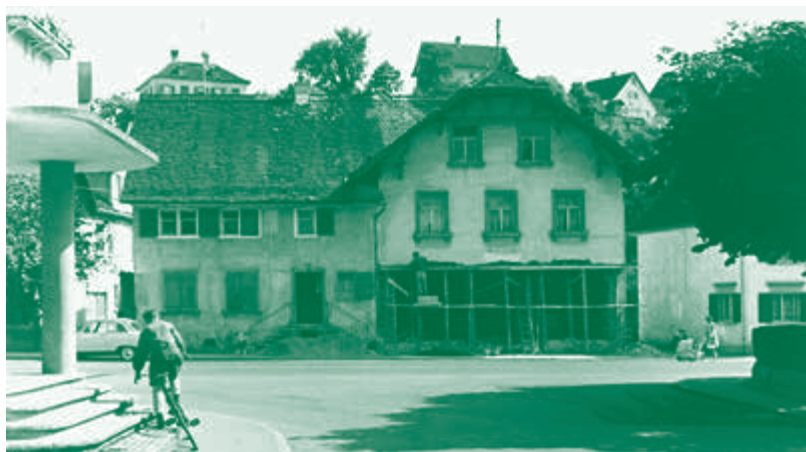
Umbau des Pircherhauses in der Ringstraße, wohl zu Beginn der 1970er Jahre. Ganz links der Eingangsbereich des 1976 abgebrochenen Volksbankgebäudes.
