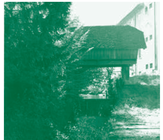
Die „Unteren Läden“ verdanken ihren Erhalt dem Umstand, dass sie den Einlass von Wasser in den Mühlbach gewährleisteten, wenn die Turbine der ehemaligen Spinnereifabrik abgeschaltet werden muss.
